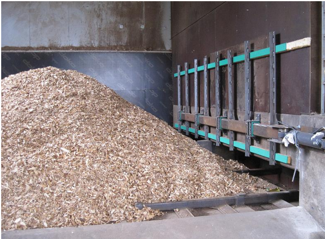
Uudet purkaimet alakylän laitoksen siilon seinällä torjumassa hakkeen holvaantumista.
